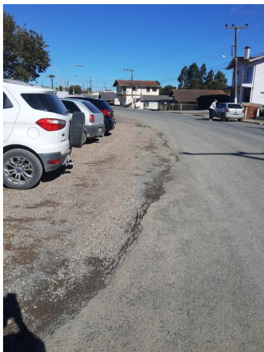
Foto 06 – Passeios a executar
