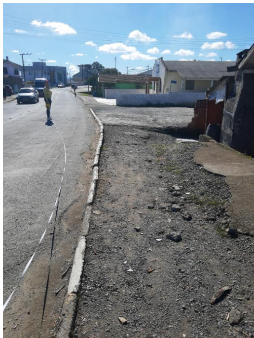
Foto 08 – Passeios a executar
