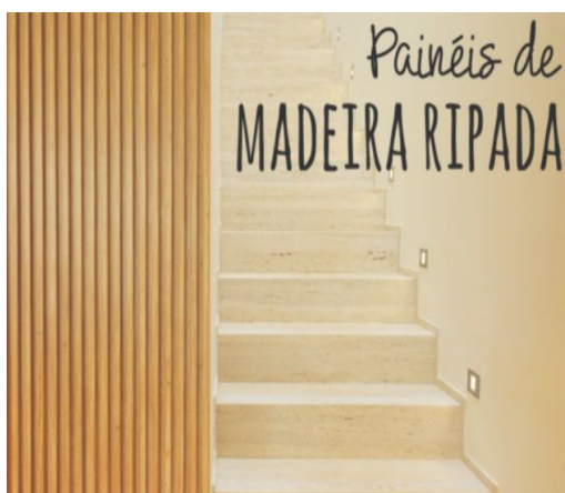
Figura 13 – Ilustração do Painel em Madeira e do Revestimento em Pedra Ferro (Fonte: Autora/2020)
