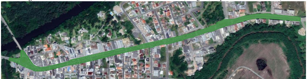
Figura 3 - Avenida Olinkraft (Trecho dos Bairros Pinheiros, Targino, Poço Rico e Vila Brasília).
